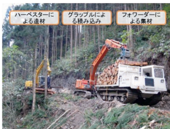
写真 2.5.6 造材と集材作業
