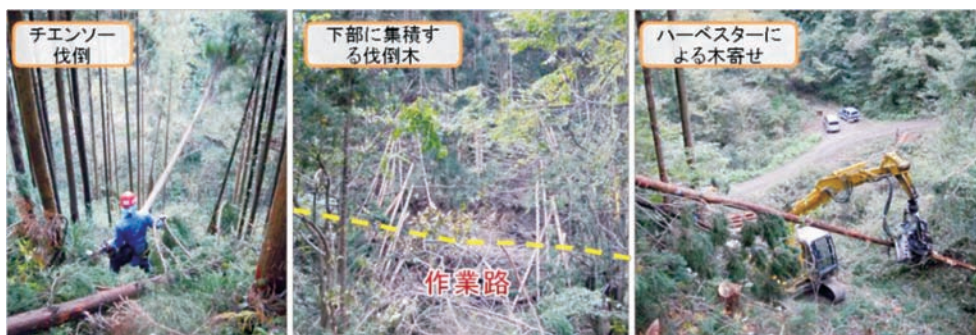
写真 2.5.4 列状間伐作業
